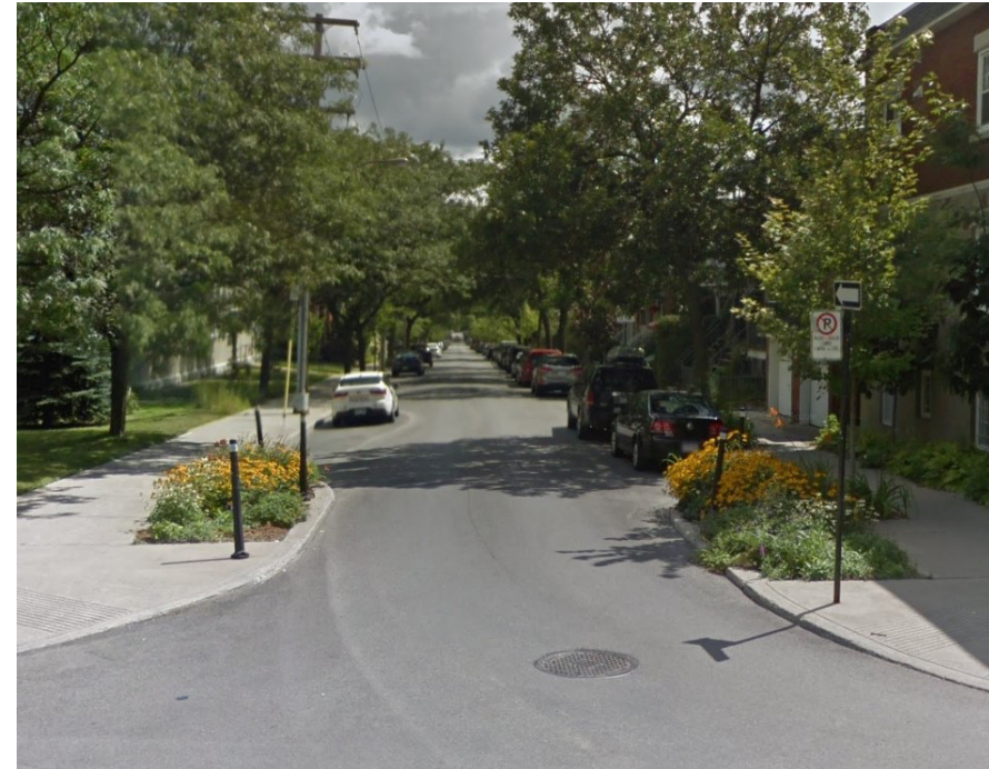
FIGURE 44: SAILLIE DE TROTTOIR AMÉNAGÉE À MÊME L'EMPRISE DE LA VOIE DE CIRCULATION (CRÉDIT PHOTO : GOOGLE)
