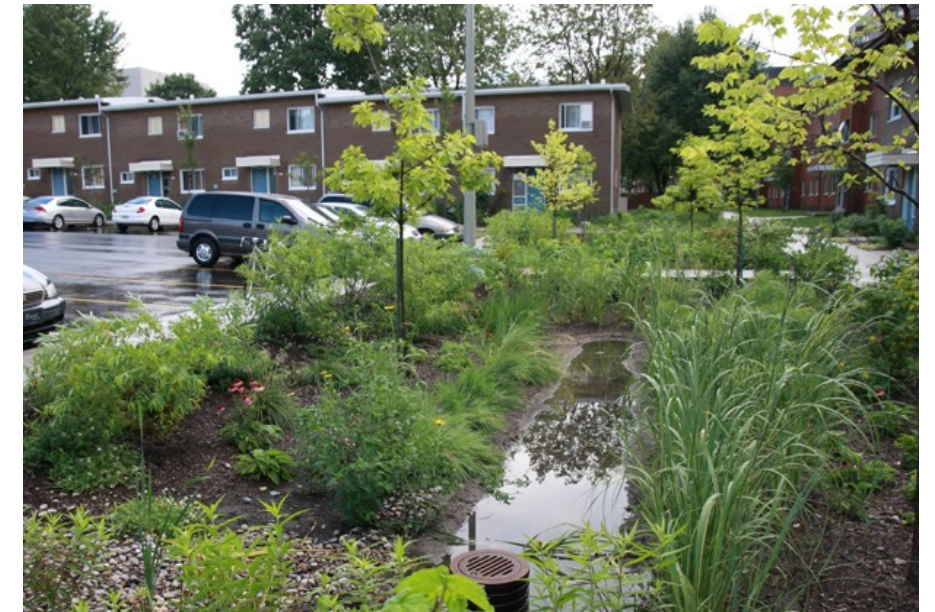
FIGURE 37: ÎLOT VÉGÉTALISÉ AU SEIN D'UNE AIRE DE STATIONNEMENT LIMITANT LA SUPERFICIE IMPERMÉABLE (CRÉDIT PHOTO : DÉMARCHÉ STATIONNEMENT ÉCORESPONSABLE)
