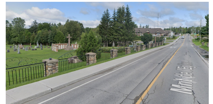
FIGURE 24: TROTTOIR DU CÔTÉ OUEST DE LA MONTÉE DE L'ÉGLISE
