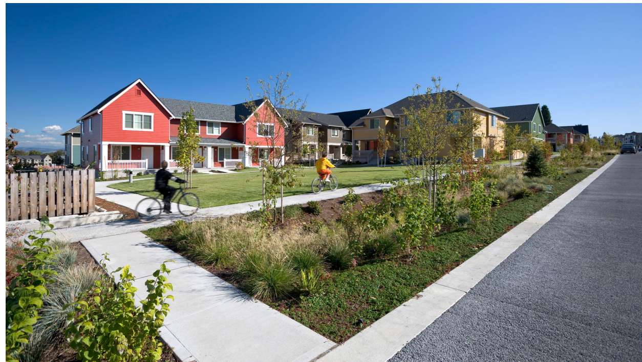
FIGURE 49: EMPRISE PUBLIQUE AMÉNAGÉE DE NOUES DRAINANTES PAYSAGÈRES (CRÉDIT PHOTO : GOOGLE)
