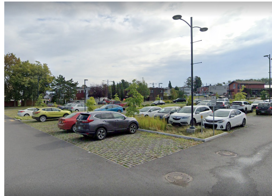
FIGURE 36: CASES DE STATIONNEMENT EN PAVÉ ALVÉOLÉ AU SEIN DU STATIONNEMENT PIERRE-LAPORTE À VICTORIANVILLE (CRÉDIT PHOTO : GOOGLE)
