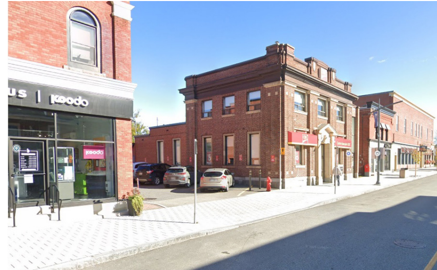
FIGURE 34: IMPLANTATION DES AIRES DE STATIONNEMENT EN COUR LATÉRALE À MAGOG (CRÉDIT PHOTO : GOOGLE)
