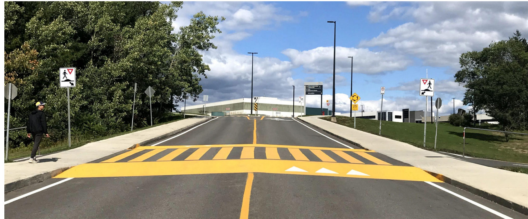
FIGURE 46: TRAVERSE PIÉTONNE AMÉNAGÉE SURÉLEVÉE (CRÉDIT PHOTO : PIÉTONS QUÉBEC)
