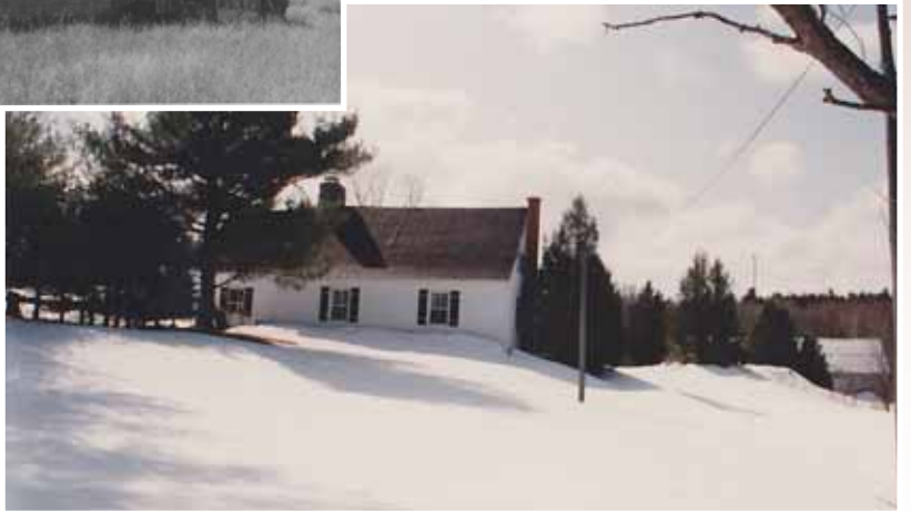
Site 34 / Maison McAndrews
